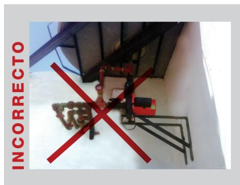
Se encuentran invertidas las conexiones correspondientes a la entrada y salida de agua al presurizador.
